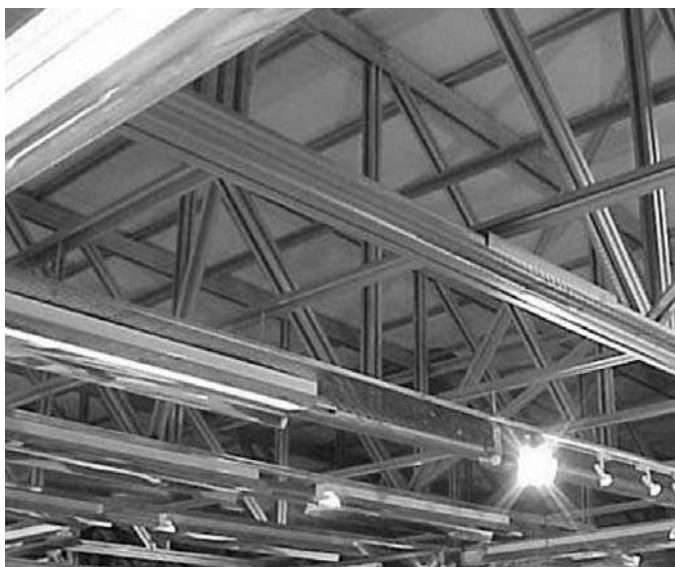
Foto 5.1- Vigas de Celosía planas . (Fuente: http://www.aegis-metalfra-ming.com ).
