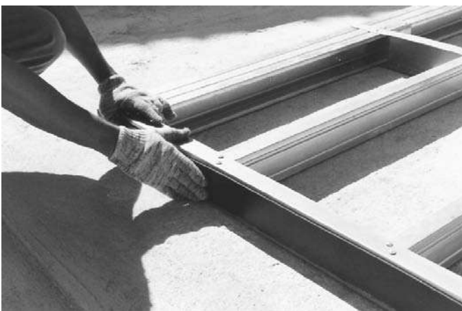
Foto 7.5 -Aplicación de la cinta sellante en la base del panel. (Fuente: Archivo del autor)
