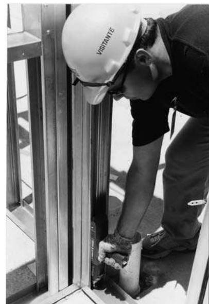
Foto 7.7 -Anclaje provisorio con pernos de acero. (Fuente: Archivo del autor)
