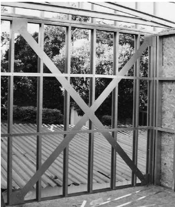
Foto 3.4 - Panel con arriostramiento en "X" Cruz de San Andrés (Fuente: Archivo del autor)
