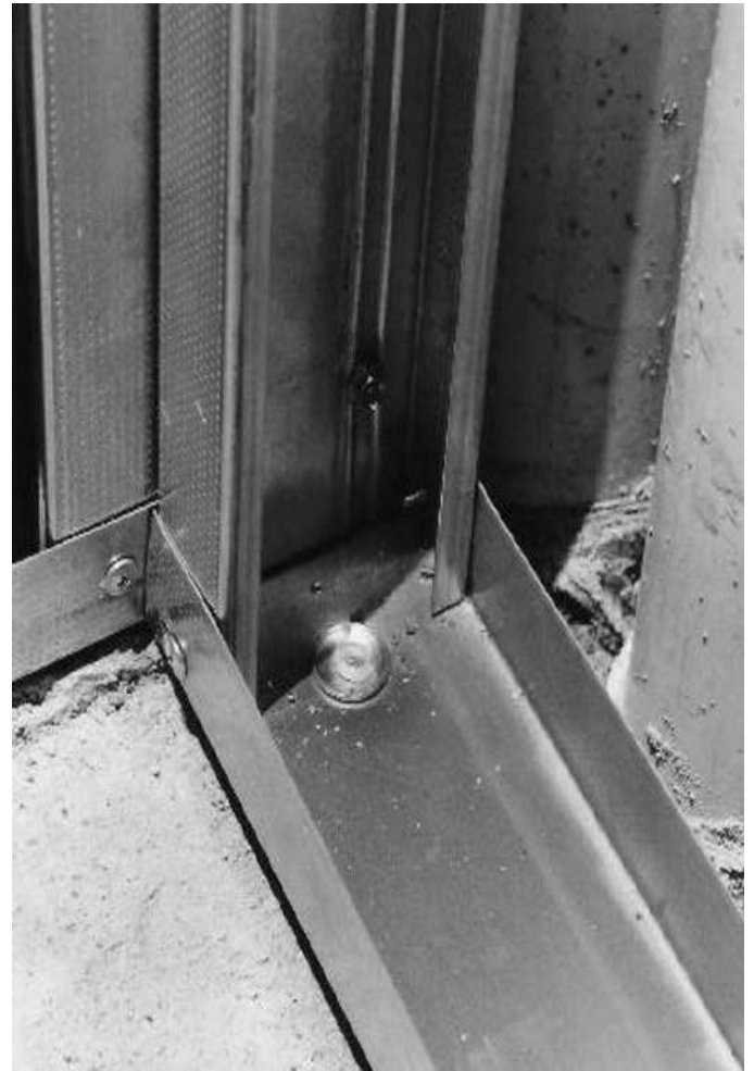
Foto 2.32 -Anclaje provisorio. (Fuente: Archivo del autor)
