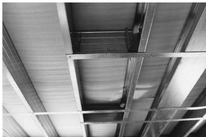
Foto 4.8 -Rigidización horizontal de entepiso por medio de bloqueadores y cintas metálicas (flejes) (Fuente: Archivo del autor)
