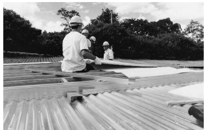
Foto 4.3 -Encofrado de acero para entrepiso húmedo (Fuente: Archivo del autor).
