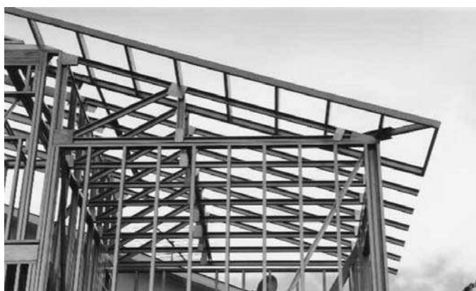
Foto 2.8 - Estructura del tejado de vivienda en Steel Framing. (Fuente: Archivo del autor)
