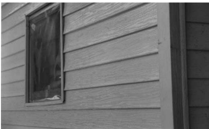
Foto 6.6 - Perfiles accesorios para la instalación del "siding" vinílico, en el detalle acabado para escuadras y esquineros. (Fuente: Archivo del autor)
