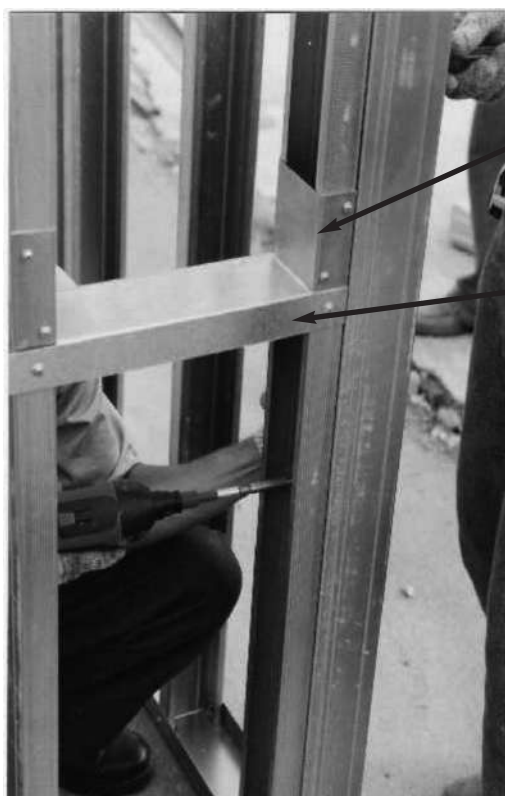
Foto 3.9 - Bloqueador y cinta de acero galvanizado fijados al panel para rigidización horizontal (Fuente: Archivo del autor)
