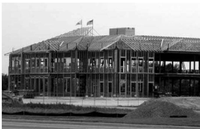
Foto 5.9 - Techo con intersección de varios planos.(Fuente: http://www.aegismetalframing.com ).
