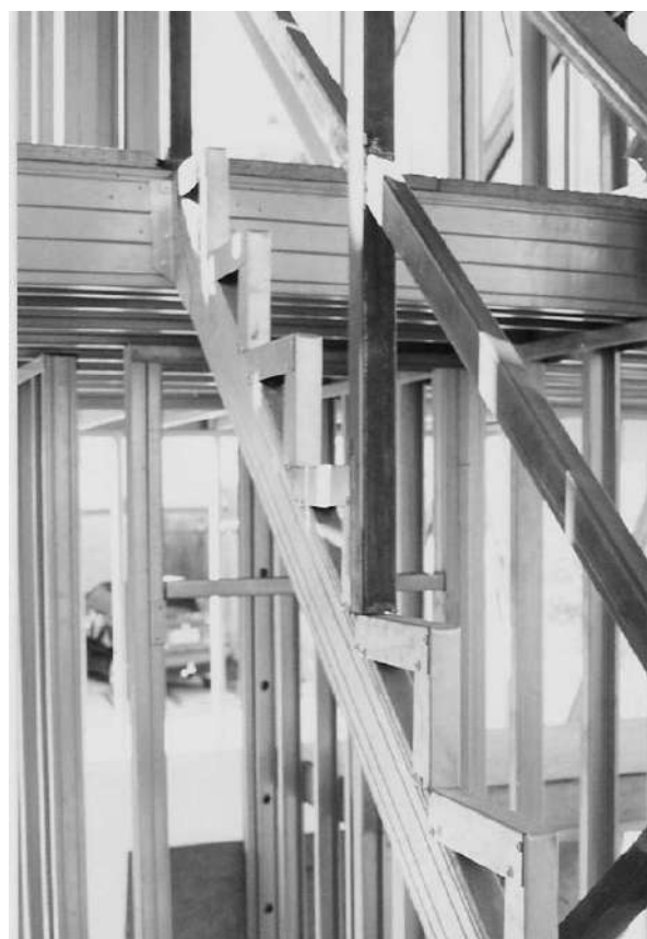
Foto 4.9 - Escalera viga cajón inclinada. (Fuente: Archivo del autor)
