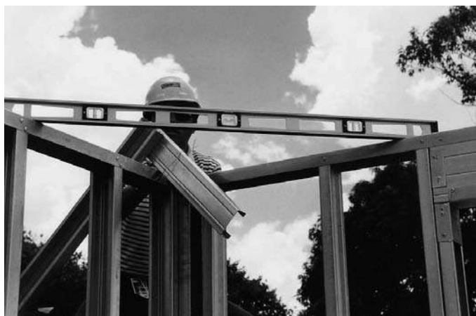
Foto 7.9 - Verificación del nivel del panel y fijación del anclaje. (Fuente: Archivo del autor)
