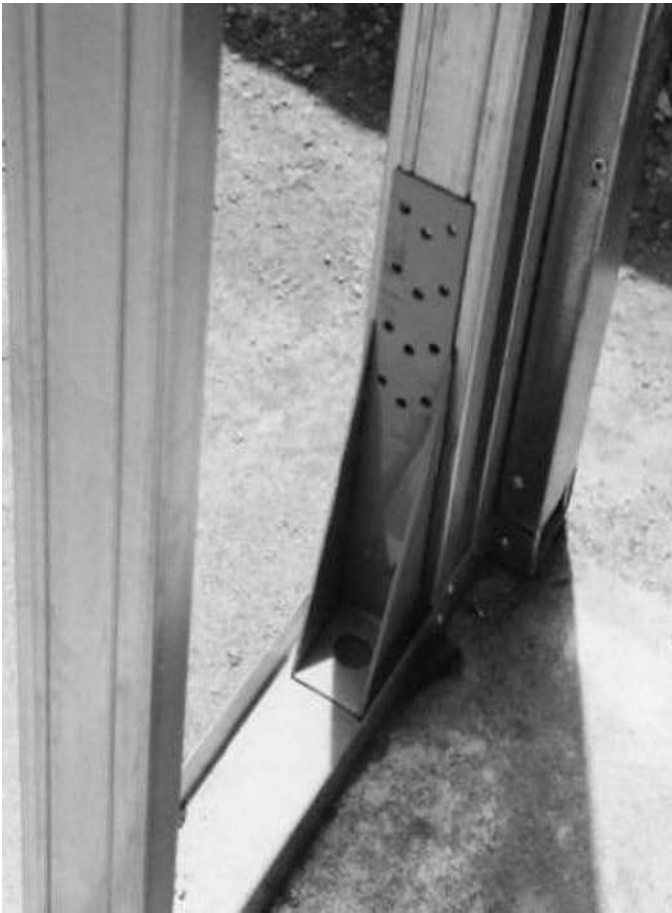
Foto 2.30- Detalle de la pieza de refuerzo en el anclaje de la estructura a la fundación por medio de varilla roscada. (Fuente: Archivo personal)
