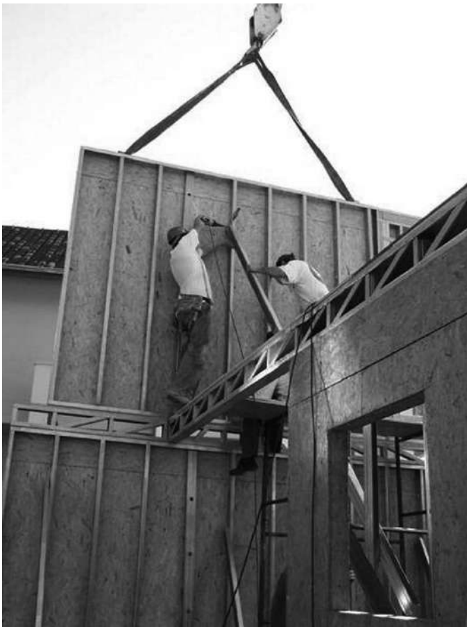
Foto 7.18 - Izamiento y posicionamiento de panel de piso superior. (Fuente: disponible en: http://www.lds.com.br/steel-frame/montaje_023_gr.jpg )
