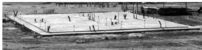
Foto 2.29- Platea de hormigón (Fuente: Disponible en: www.metálica.com.br )
