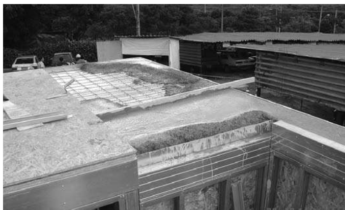
Foto 7.16 - Ejecución de losa húmeda. (Fuente: Usiminas)
