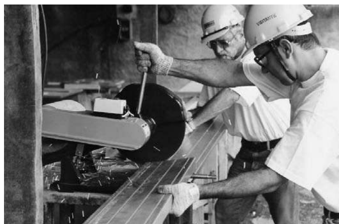
Foto 7.3 - Corte de los perfiles con sierra circular. (Fuente: Archivo del autor)
