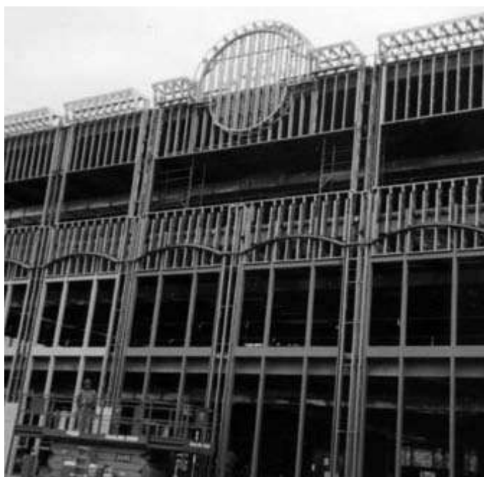
Foto 3.13 - Paneles presentando diversas formas curvas. (Fuente: disponible en: http://www.aegismetalframing.com ).
