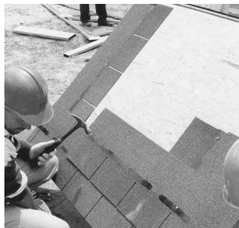
Foto 5.11 - Demostración de instalación de tejas "shingles" sobre placas de OSB. (Fuente: Archivo del autor)
