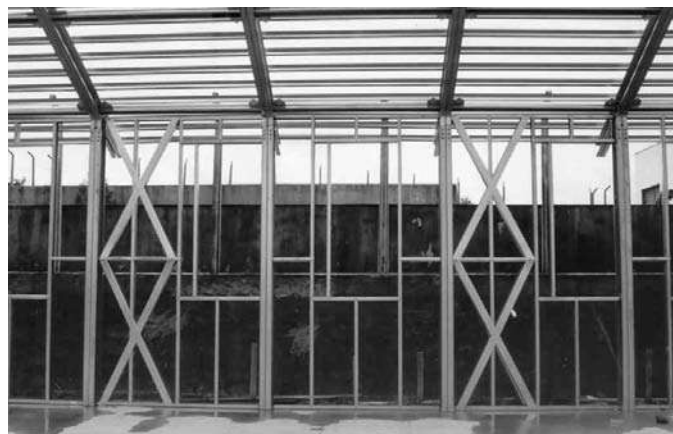
Foto 3.5 - Paneles arriostrados en función de las aberturas en el laboratorio en la Universidad Federal de Ouro Preto. (Fuente: Archivo Célio Firmo).
