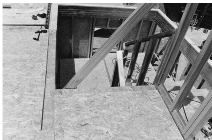
Foto 4.4 - Placas de OSB utilizadas como entrepiso seco. (Fuente: Archivo del autor)
