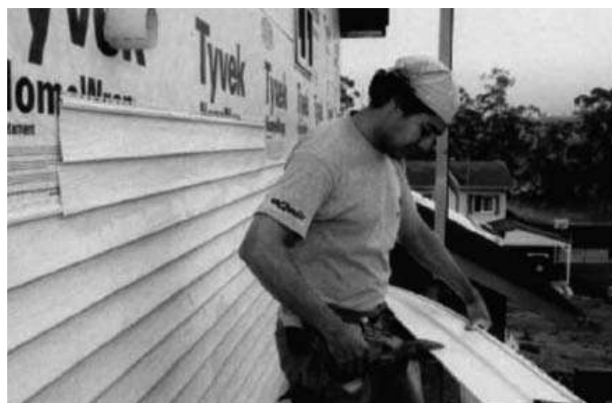
Foto 6.5 Instalación de siding vinílico. (Fuente: Marcos Lima 1 )
