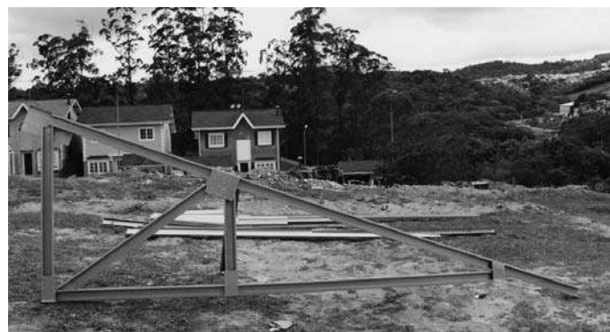
Foto 5.8 - Cabriada de "media agua" cuyos elementos están fijados en placas metálicas de acero (placas de Gusset). (Fuente: Archivo del autor)
