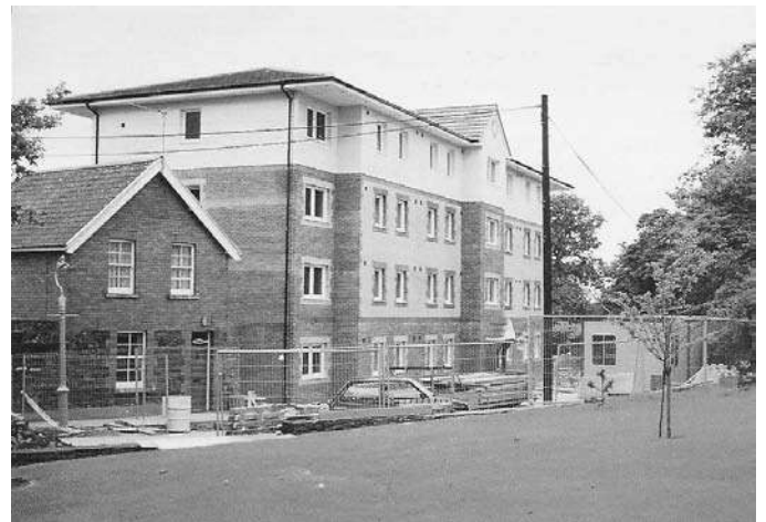
Foto 2.16 - Edificio en Inglaterra. (Fuente: SCI)
