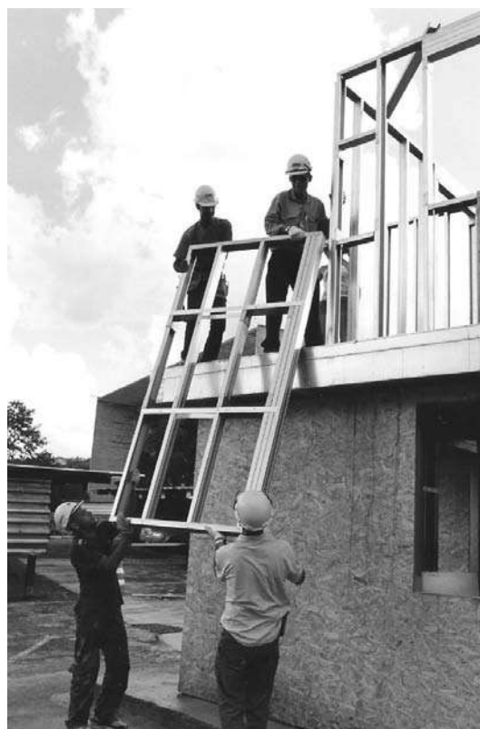
Foto 7.17 - Montaje de paneles del piso superior. (Fuente: Archivo del autor)
