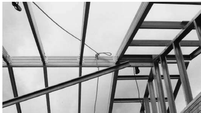
Foto 5.3 - Cumbrera compuesta de perfiles U y C como apoyo de los cabios (Fuente: Archivo del autor)
