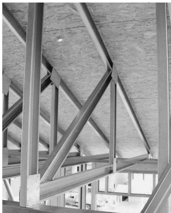
Foto 5.10 - Placas de OSB para la fijación de tejas "shingles" (Fuente: Archivo del autor).
