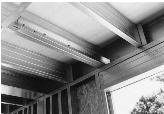
Foto 4.5 -Film de polietileno entre vigas de entrepiso y contrapiso con placas de OSB. (Fuente: Archivo del autor)
