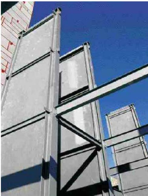
Fig. 3-23. Ejemplo de muros de corte con placas de acero en un edificio en construcción.
