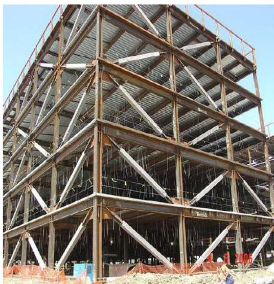
Fig. 3-19. Pórtico de acero con riostras de pandeo restringido.
