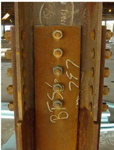
Fig. 3-55. Empalme en columna con cambio de sección.
