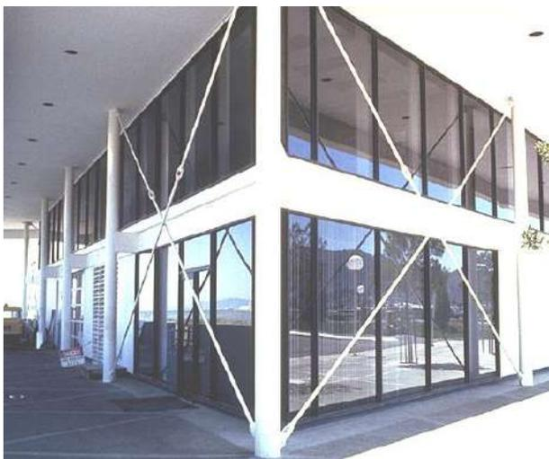
Fig. 5-19. Pórtico arriostrado con tensores en X.
