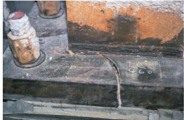
*Fig. 1-13. Fractura en una placa de base de columna de una estructura de pórtico arriostrado ([Earthquake Engineering Research Institute, Slides on the January 17, 1994, Northridge Earthquake, Set I: An Overview](#)).*
