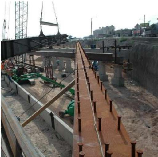
Fig. 1-33. Imagen de una viga de acero con pernos de corte para construcción de la viga compuesta de un puente.
