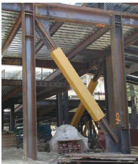
Fig. 3-20. Vista de una riostra de pandeo restringido utilizada en nuevo edificio de la Universidad de California, Berkeley (Cortesía de EERC, University of California, Berkeley).
