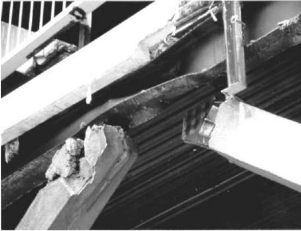
Fig. 1-17. Daño severo en la viga y conexión de un pórtico con arriostramientos en V invertida (Naeim, 2001).
