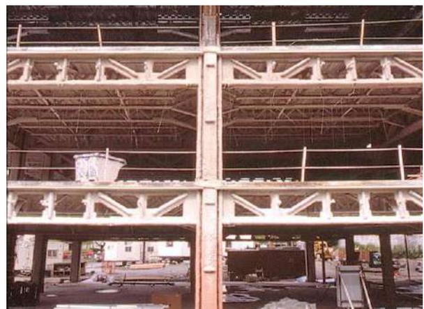
Fig. 3-4. Pórtico no arriostrado con vigas reticuladas, que incluyen 2 segmentos con panel Vierendeel ([Chao y Goel, 2006](#)).
