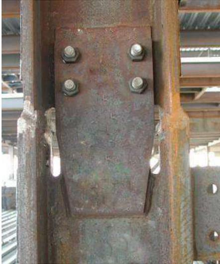
Fig. 3-57. Empalme en columna con cambio de sección.
