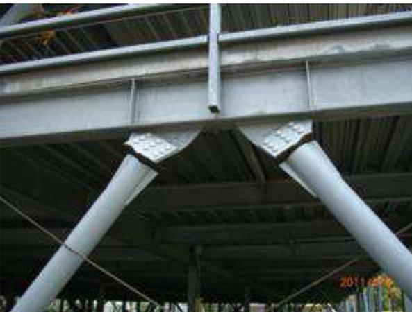
Fig. 1-19. Fractura de riostras en la zona de conexión (Midorikawa et al., 2012).
