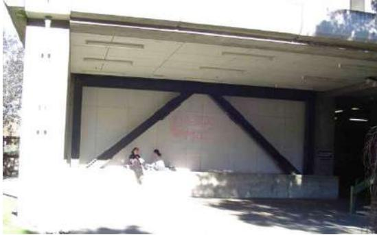
Fig. 6-18. Pórtico arriostrado excéntricamente adosado a una construcción de hormigón armado existente.
