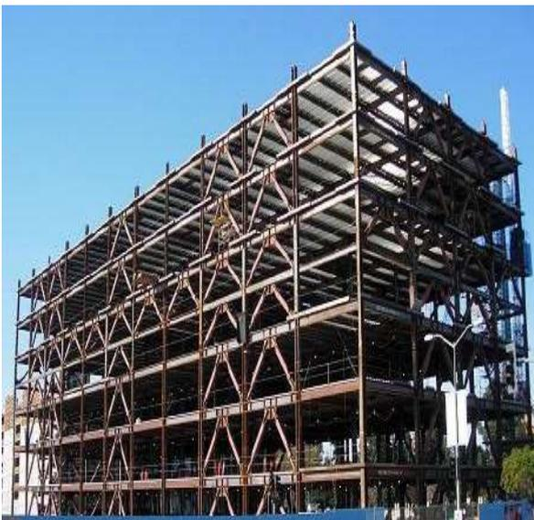
Fig. 3-6. Vista de un edificio en construcción con pórticos arriostrados.
