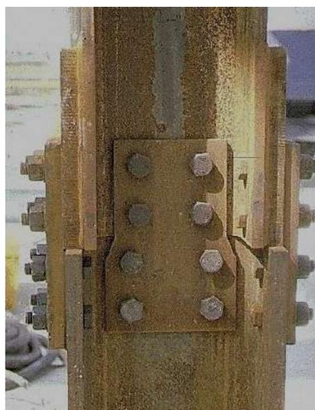
Fig. 3-56. Empalme en columna con cambio de sección.
