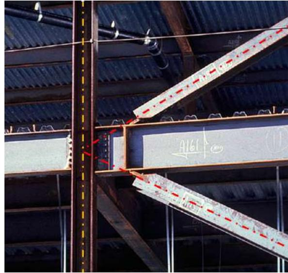
Fig. 3-7. Detalle del nudo de un pórtico arriostrado con una conexión concéntrica (sin excentricidad).
