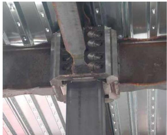
Fig. 4-22. Conexión "ConXtech ConXL" (AISC, 2010c).
