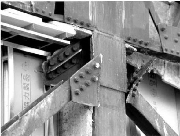
Fig. 1-18. Fractura en una conexión soldada (Naeim, 2001).
