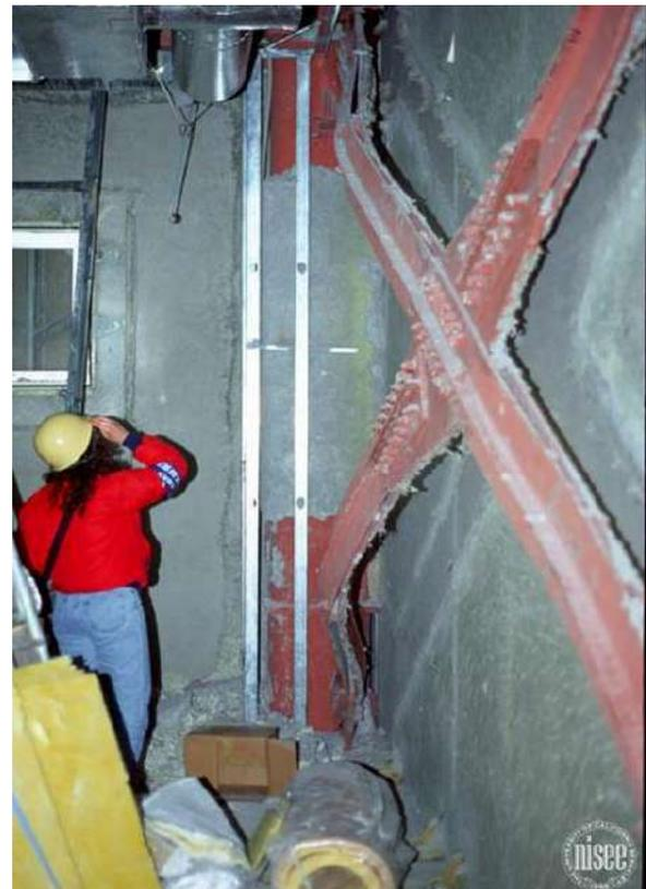
*Fig. 1-6. Pandeo de una riostra, terremoto de Hyogo-ken Nanbu, Japón (Cortesía de National Information Service for Earthquake Engineering, EERC, University of California, Berkeley).*
