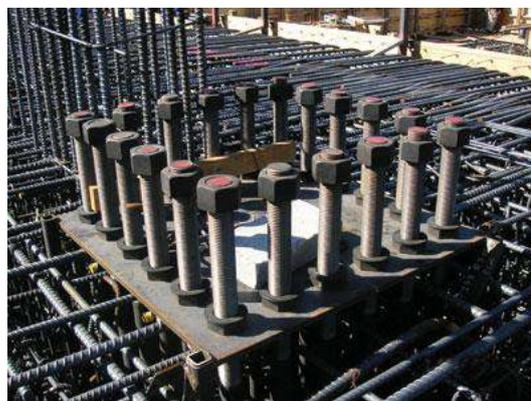
Fig. 3-62. Ejemplo de base de columna embebida en una viga de fundación de hormigón armado (<http://www.structuremag.org>).
