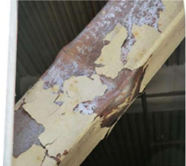
Fig. 1-20. Pandeo local en el extremo de una riostra de acero (Midorikawa et al., 2012).
