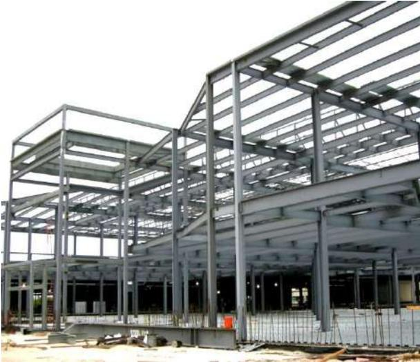
Fig. 3-2. Vista general de una estructura de pórticos no arriostrados para un edificio comercial.
