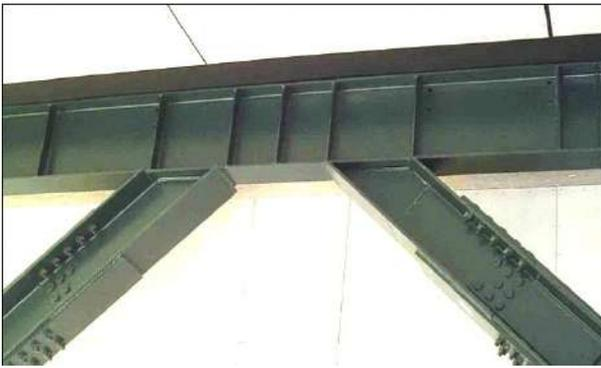
Fig. 3-16. Detalle del enlace en un pórtico con arriostramientos excéntricos
