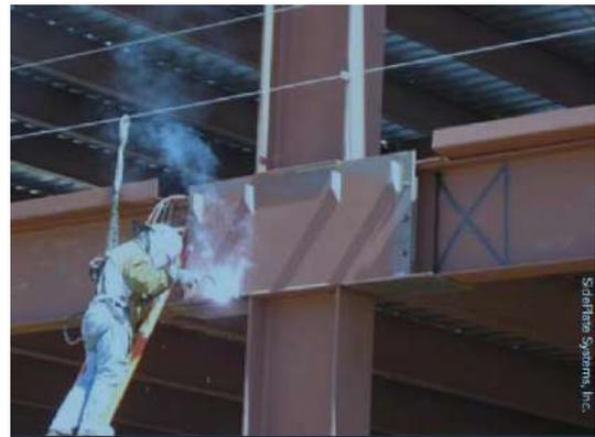
Fig. 3-19. Conexión con placas laterales.
