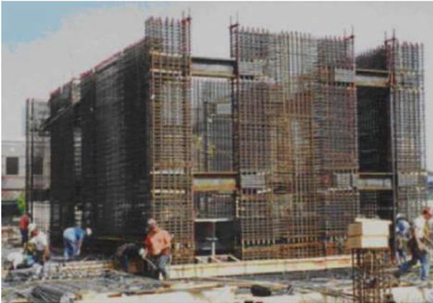
Fig. 3-45. Muros compuestos acoplados con vigas de acero (Lehmkuhl, 2002).
