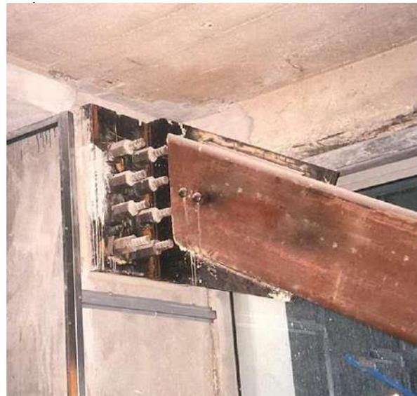
Fig. 5-40. Detalle de la conexión de una riostra de acero al nudo de un pórtico existente de hormigón armado.
